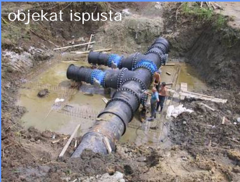
objekat na cjevovodu (šaht zatvarača)
